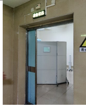
DSA 机房东南侧（胃肠机房等）
