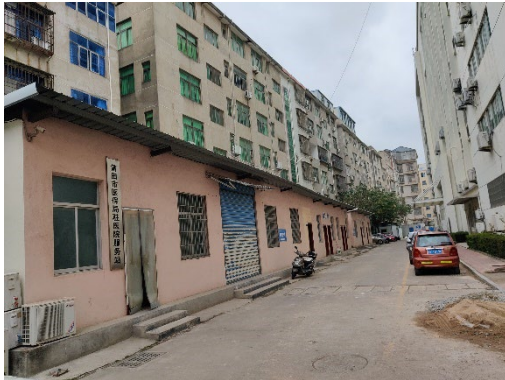
DSA 机房西南侧（院内道路等）
